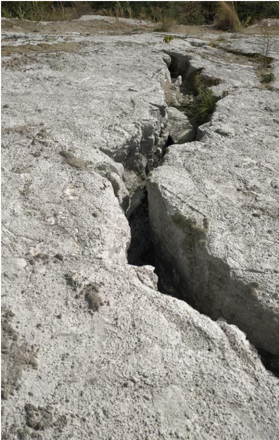
Рис. 3. Фото поверхні Дніпровського хвостосховища: a – загальний вигляд; b – тріщини в покривних фосфогіпсах; c – руйнація структури фосфогіпсу
