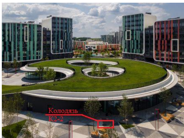
Рис. 1. Адміністративна будівля з «зеленою» покрівлею та колодязь K2-2
