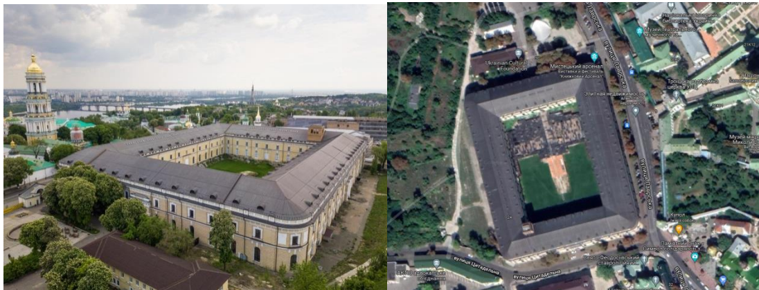
Рис. 1. Загальний вигляд будівлі «Арсенал» та прилеглої території Fig. 1. General view of the Arsenal building and the surrounding area
