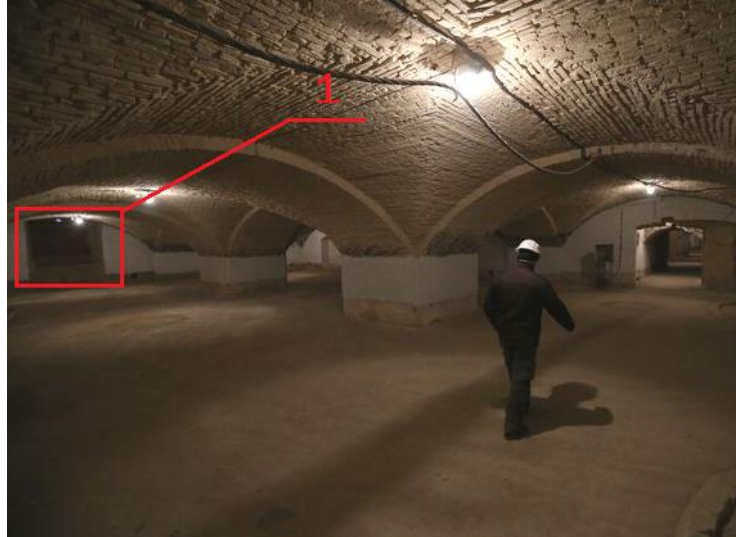
Рис. 2. Фото підвальної частини будівлі «Арсеналу», де цифрою 1 позначена зона необхідного відновлення історичного приямку для можливості прокладання пожежних рукавних ліній на потреби пожежогасіння
