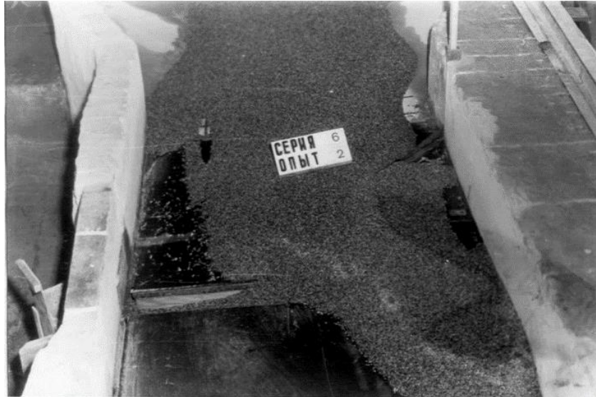
Рис. 6. Відкладення наносів в траншейній піскогравієловці Fig. 6. Sediment deposition in trench sand and gravel catcher
